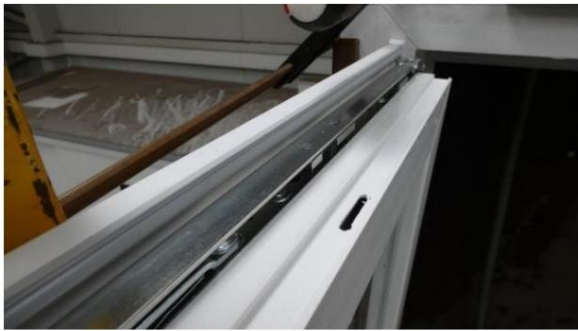
Foto.9 Traverso superiore anta, feritoia di ventilazione e cerniera forcice
