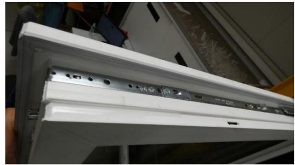
Foto.10 Traversa superiore dell'anta, sigillatura dell'angolo; fessura di ventilazione visibile
