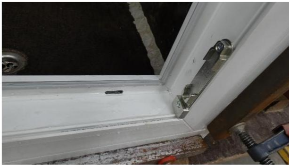
Foto.15 Sigillatura angolo inferiore telaio destro; visibile riscontro ad inclinazione verticale e feritoia di ingresso drenaggio
