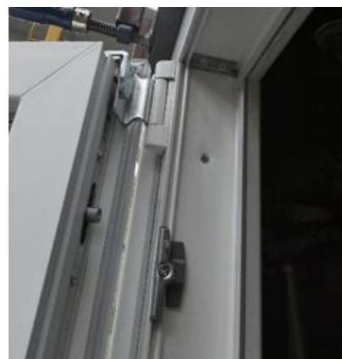
Foto 16 Sigillatura del telaio medio dell'anta e del collegamento superiore dei montanti; punto di chiusura a vista e cerniera superiore dell'anta centrale
