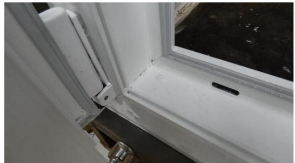
Foto.6 Sigillatura del corrispondente collegamento inferiore telaio e montante; riscontro verticale con inclinazione a vista, fessura di ingresso scarico e cerniera inferiore dell'anta centrale
