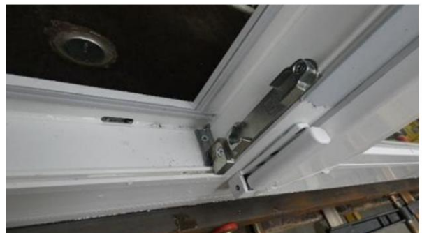
Foto.6 Sigillatura del corrispondente collegamento inferiore telaio e montante; riscontro verticale con inclinazione a vista, fessura di ingresso scarico e cerniera inferiore dell'anta centrale
