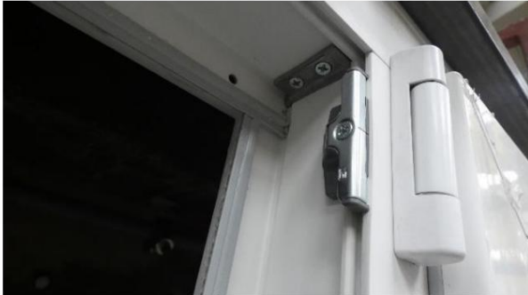
Foto.9 Barra superiore anta sinistra; fessura di ventilazione visibile e raccordo cerniera forcice
