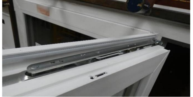
Foto.22 Barra inferiore anta centrale; fessure di drenaggio visibili
