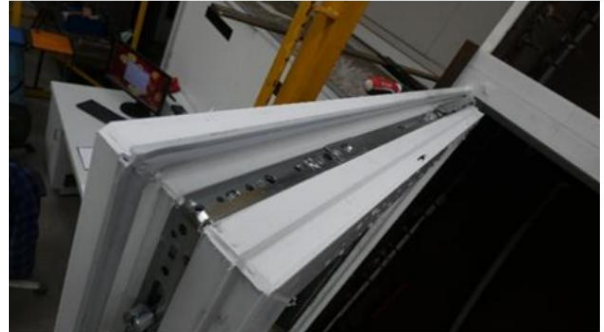
Foto.10 Barra inferiore anta sinistra; fessure di drenaggio visibili
