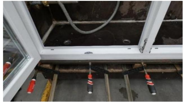
Foto.16 Soglia sezione telaio anta sinistro; guarnizioni, raccordi e fessure di drenaggio visibili
