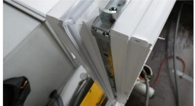
Foto.10 Cerniera inferiore – vista in posizione chiusa
