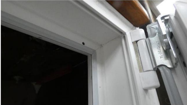
Foto.7 Sigillatura dell'angolo superiore destro del telaio; cerniera superiore visibile e apertura di ventilazione
