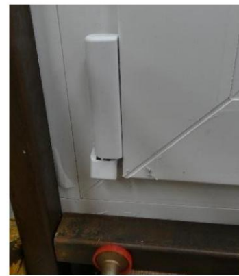
Foto.12 Sigillatura dell'angolo inferiore sinistro dell'anta destra
