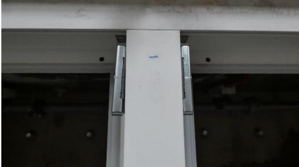
Foto.19 Confronto fissaggio riscontri superiori collegamento del montante; visibile leggera deformazione della contropiastra sinistra
