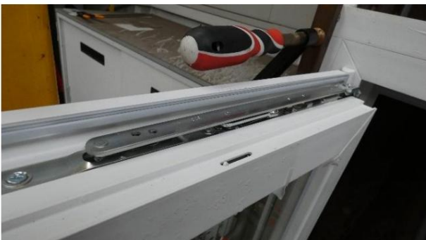
Foto.11 Barra superiore anta sinistra; fessura di ventilazione visibile e rimanere in posizione cerniera
