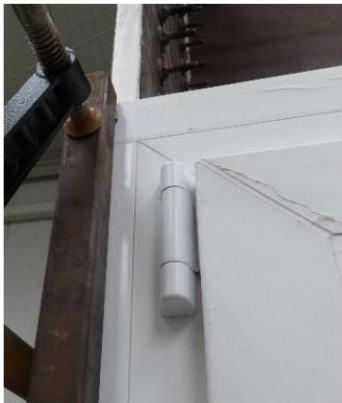
Foto.11 Barra superiore anta sinistra; fessura di ventilazione visibile e rimanere in posizione cerniera
